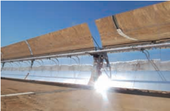
Figura 4.11.6. Detalle de campo solar de una central cilindro-parabólica
